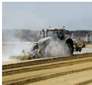
Exclusif : chantier de réfection de chemin avec un 1050 Vario
