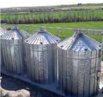
Installation de stockage, fosse, manutention fixe et boisseau
