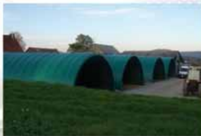
TUNNELS DE STOCKAGE
